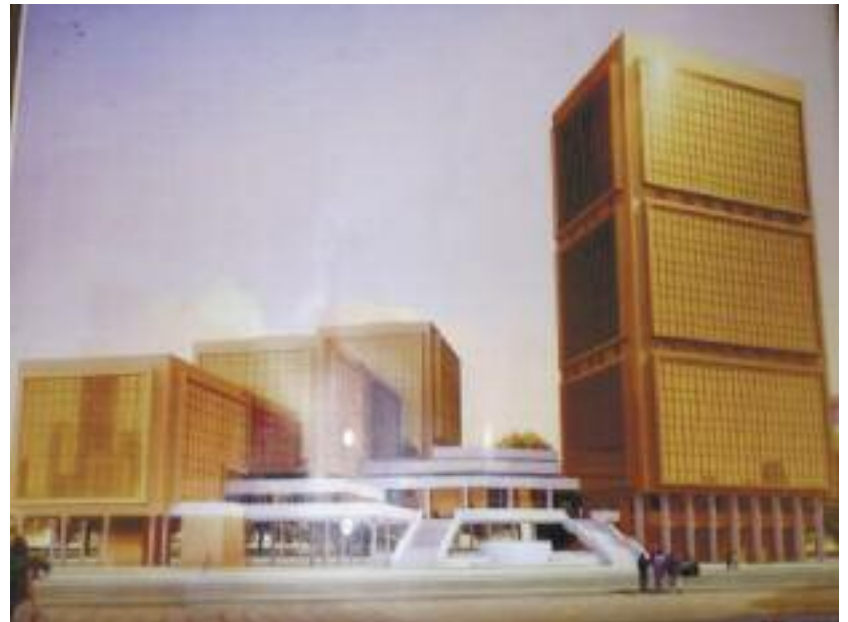
Le complexe de l'immeuble ministériel N°1 à Yaoundé réhabilité par la Cnps
