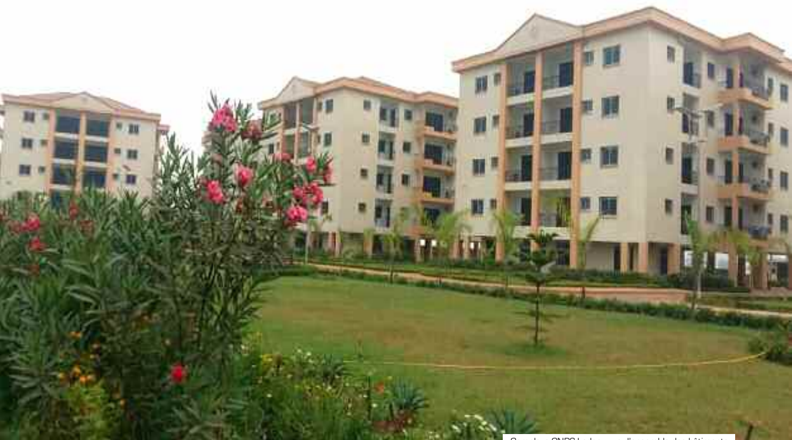
Complexe CNPS Lodge : vue d'ensemble des bâtiments
