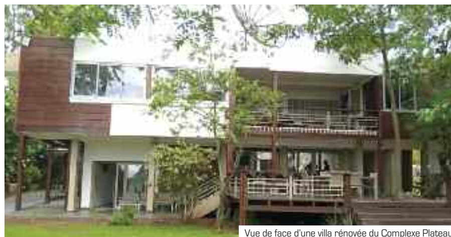
Vue de face d'une villa rénovée du Complexe Plateau
